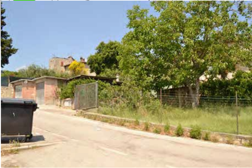
1 - Edificio privato, fortemente degradato
