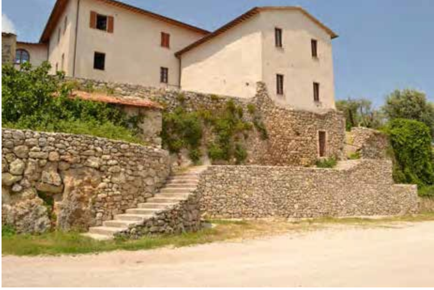
3 - Edificio privato, fin buono stato
