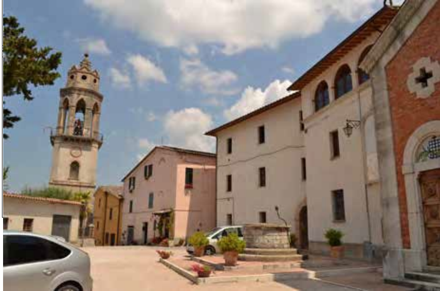
1 - Edifici utilizzati, in buono stato
